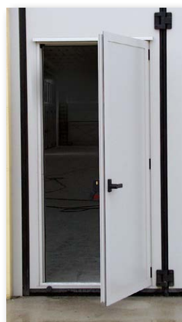
Porta pedonale di servizio, inserita su anta.
